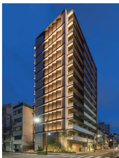
リーラ浅草橋 令和3年7月竣工
