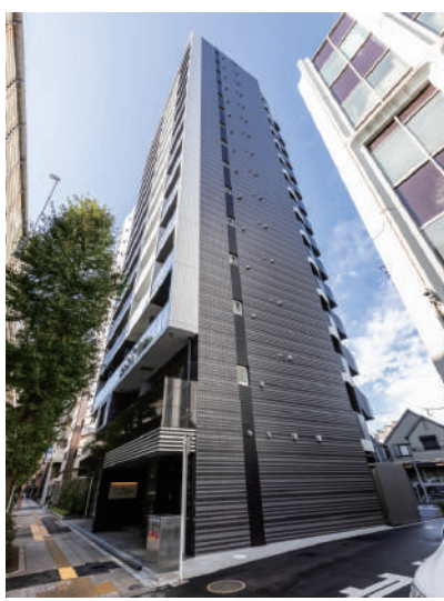
ARKMARK渋谷初台 令和5年11月竣工
