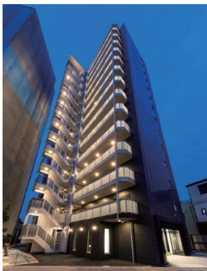
AZEST青砥 令和2年1月竣工
