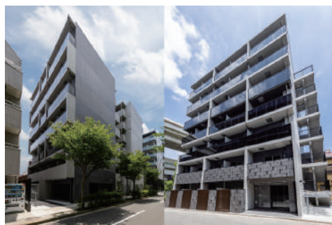
MAXIV阪東橋TWIN WEST MAXIV阪東橋TWIN EAST 令和5年6月竣工
