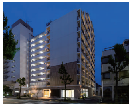
ALTERNA中野 令和5年5月竣工
