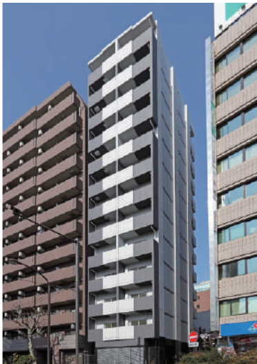
クレイシア三田 平成26年1月竣工
