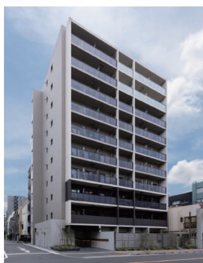
ALTERNA浅草 令和5年9月竣工
