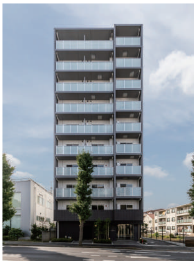
GENOVIA白糸台skygarden 令和5年10月竣工
