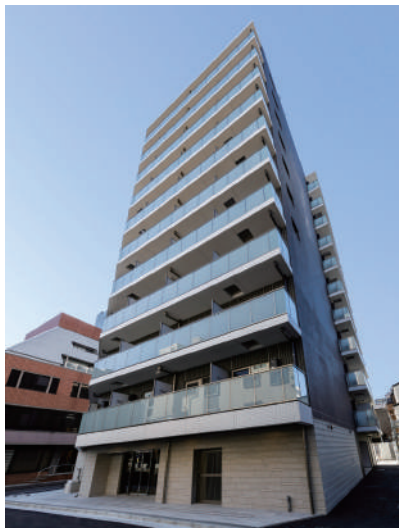
AZEST関内 令和5年3月竣工
