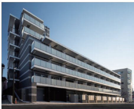
MAXIV西川口SC 令和5年12月竣工
