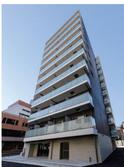
AZEST関内 令和5年2月竣工
