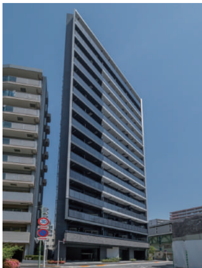
GALA STATION 大森海岸 令和5年5月竣工
