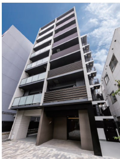
プレール・ドック池袋South 令和5年5月竣工
