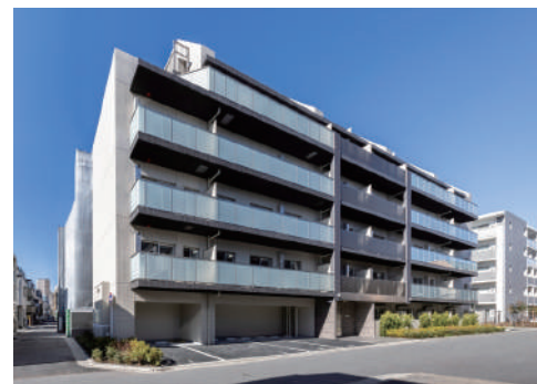
リテラス日暮里 令和6年1月竣工
