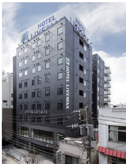
ホテルリブマックス横浜元町駅前 平成29年2月竣工
