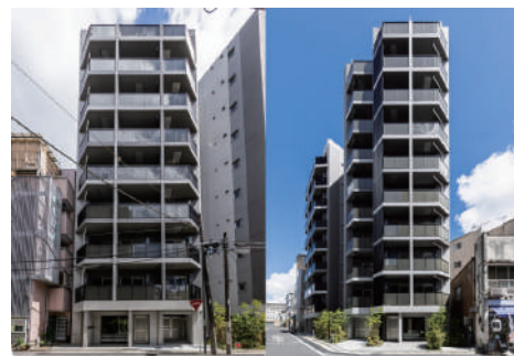
SHOKEN Residence横浜鶴見IV SHOKEN Residence横浜鶴見III 令和5年8月竣工
