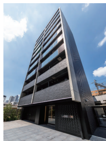
REALIZE新丸子 令和3年7月竣工
