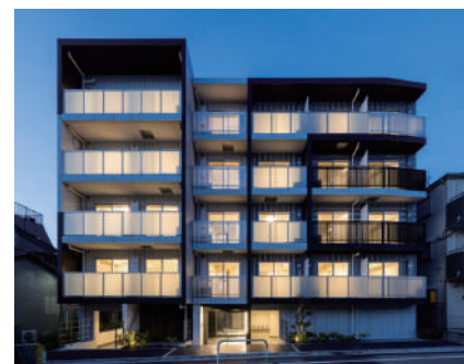
LUMEED赤羽NORTH 令和5年12月竣工
