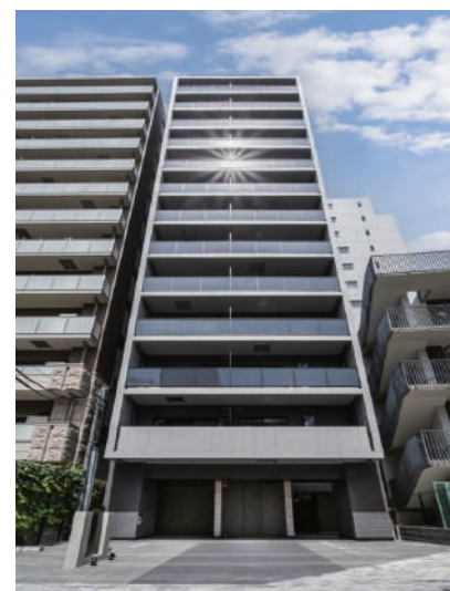
SEASON FLATS 武蔵小山 令和5年6月竣工
