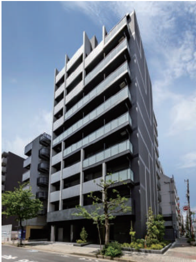
GEOVIA木場 II 令和5年6月竣工
