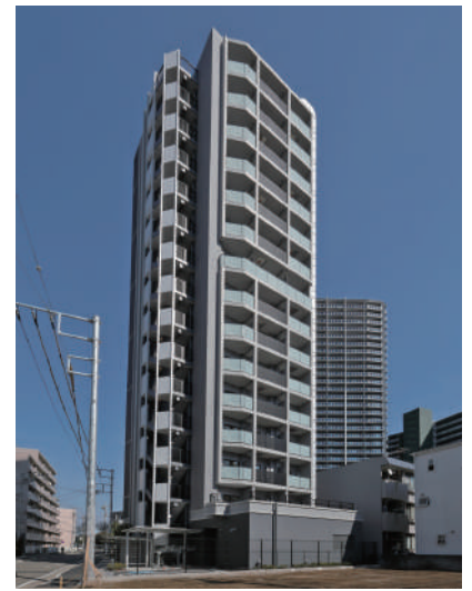
バウスクロス相模大野 令和4年2月竣工
