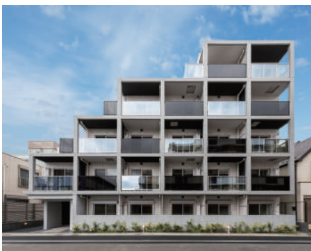
REALIZE新小岩 令和2年7月竣工
