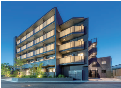
ガーラ・パークヒルズ町田 令和3年7月竣工
