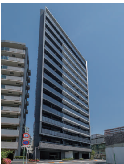
GALA STATION 大森海岸 令和5年5月竣工
