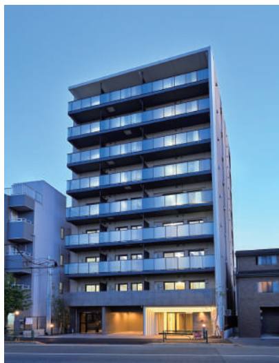
ドゥーエ南砂町 令和6年2月竣工
