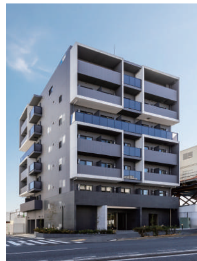
ステージファースト洗足池 令和5年1月竣工
