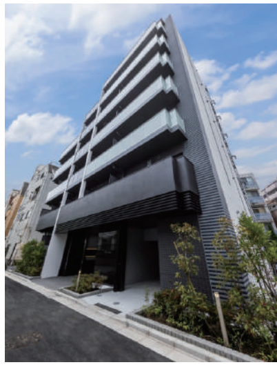
GENOVIA 押上II 令和5年6月竣工
