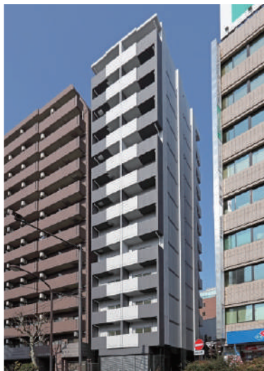
クレイシア三田 平成26年1月竣工
