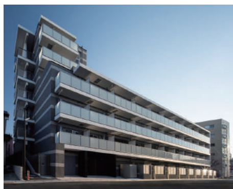
MAXIV西川口SC 令和5年12月竣工
