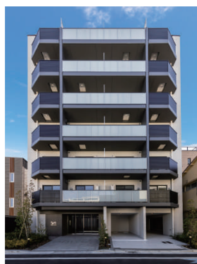
プレール・ドック木場公園WEST 令和5年2月竣工
