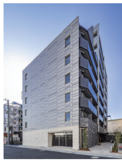
URBANPARK 行徳 STATION FRONT 令和5年11月竣工
