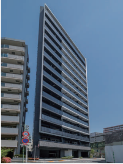
GALA STATION 大森海岸 令和5年5月竣工
