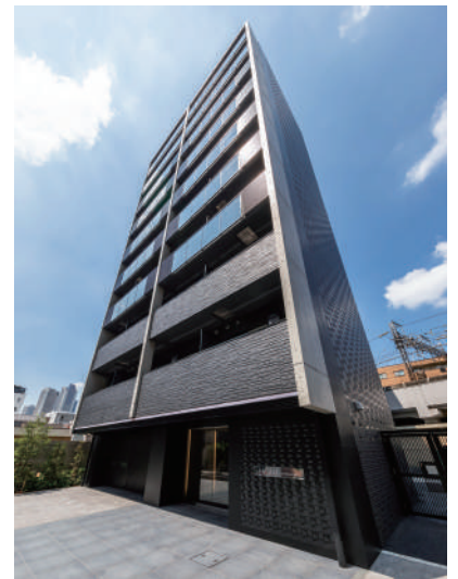
REALIZE新丸子 令和3年7月竣工
